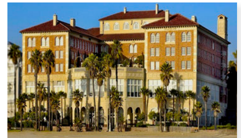
Hotel Casa Del Mar
